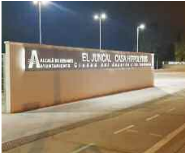
La obra ha generado 123 plazas de aparcamiento para vehículos y 4 para autobuses
